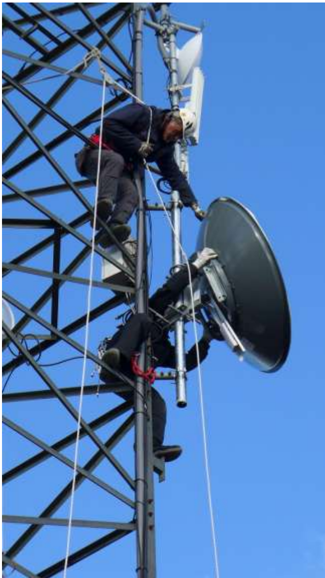
Fig. 6 Hoisting the antenna in Amiata.
